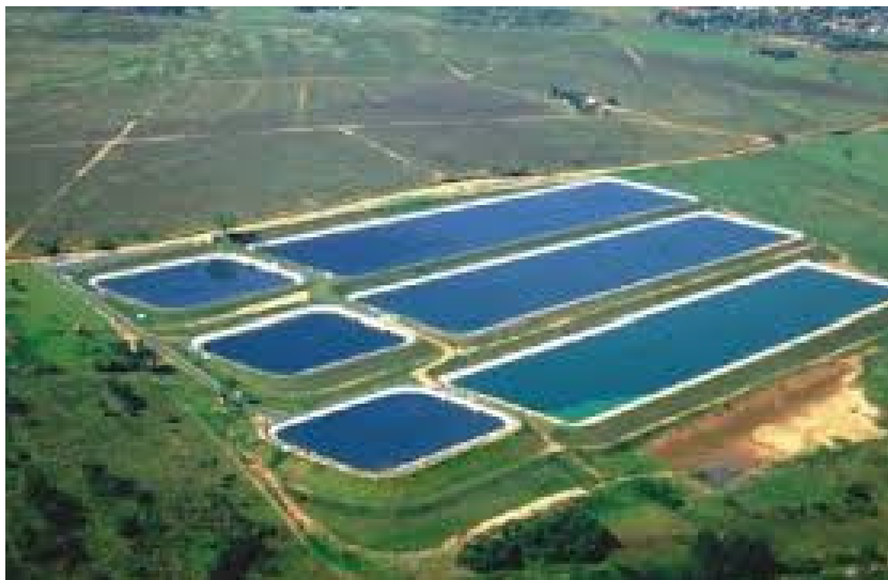
FIGURA 2: tratamento com lagoas de estabilização.
