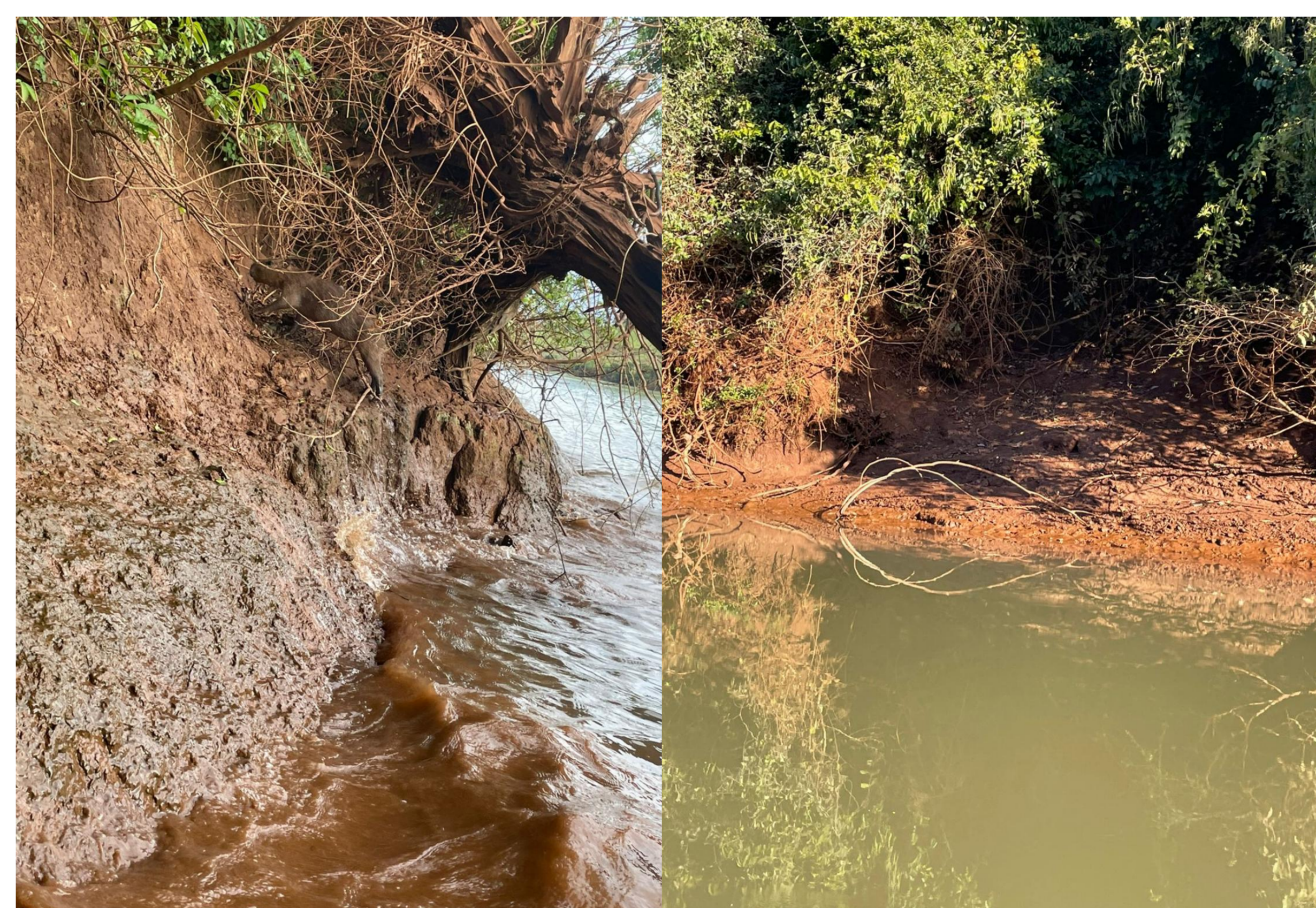
FIGURA 2: Situação observada in situ . Fonte: Registros dos autores (2025)
