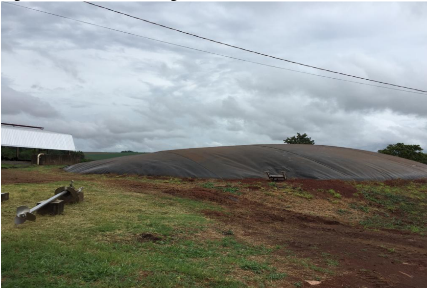
Figura 6 – Piscina do biodigestor
